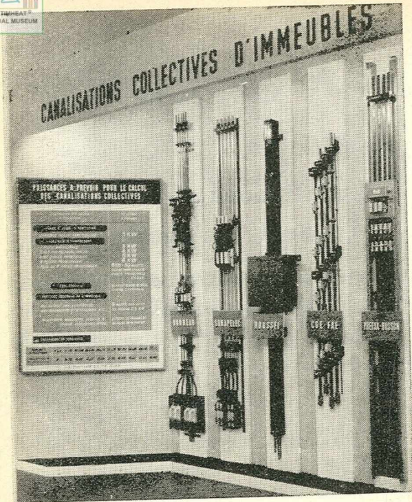
Les canalisations collectives d'immeubles types préfabriquées, présentées par l'Électricité de France au 2 e Salon International du Bâtiment et des Travaux Publics à St-Cloud en Juin 1956.
